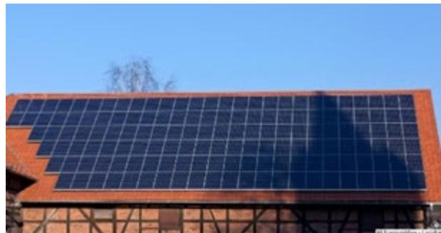
Verschattung eines Daches mit Solarpanelen durch einen Baum.
